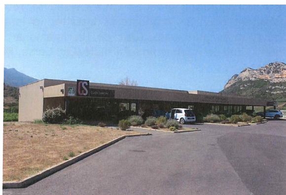
Caveau conçu pour l'accueil avec parking spacieux
