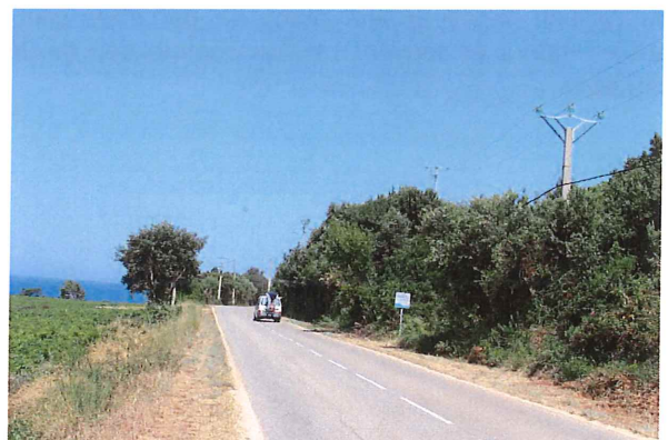
Les réseaux électriques le long des routes
