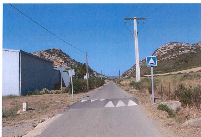
Le réseau électrique le long des routes
